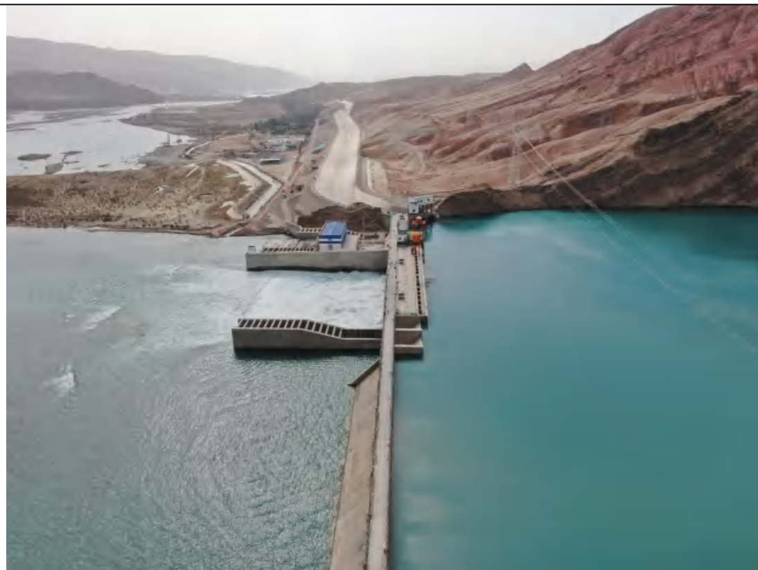
拦河引水枢纽
