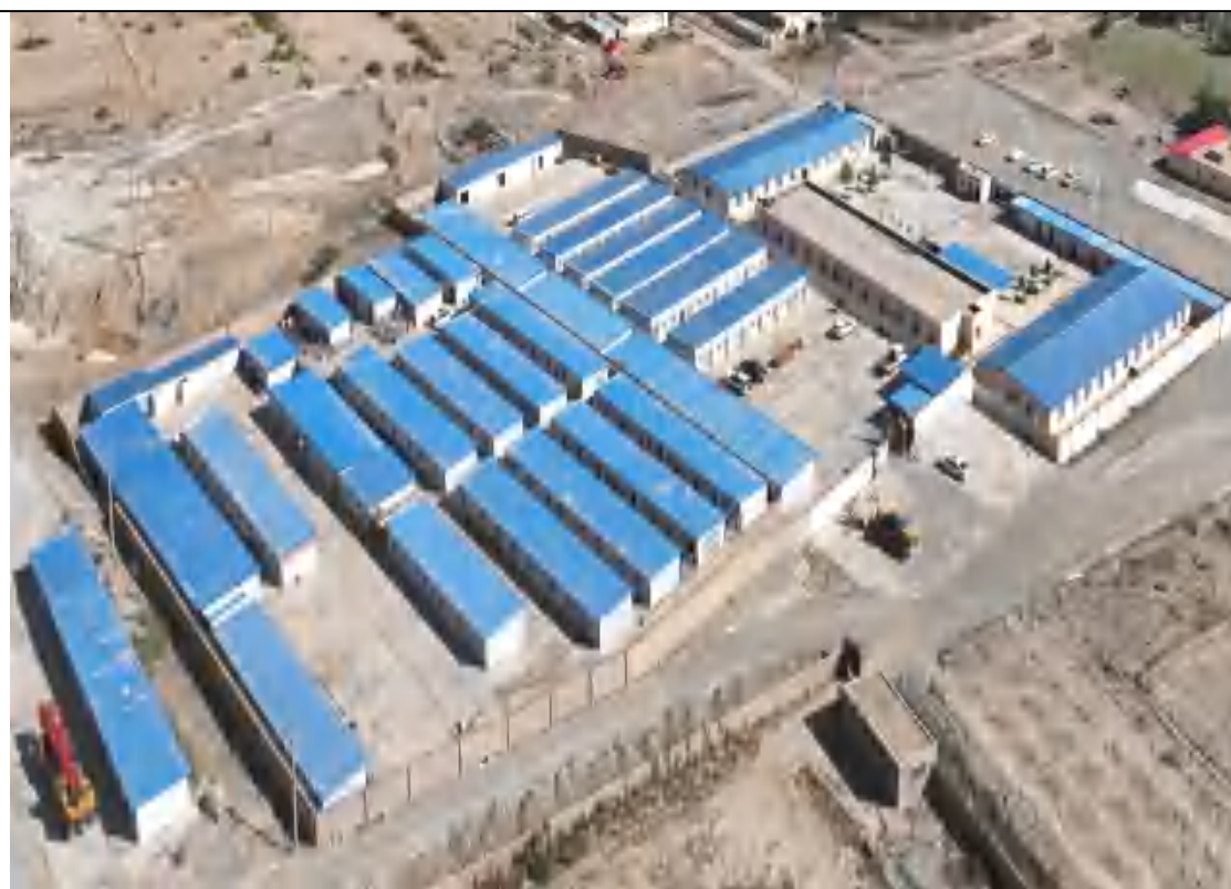
鳌高水电开发有限公司营地 (E76°38'51.47", N37°53'26.40")
