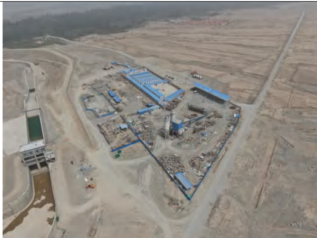
4 标-水电六局施工生产生活区 (E76°39'2.48", N37°53'3.49")
