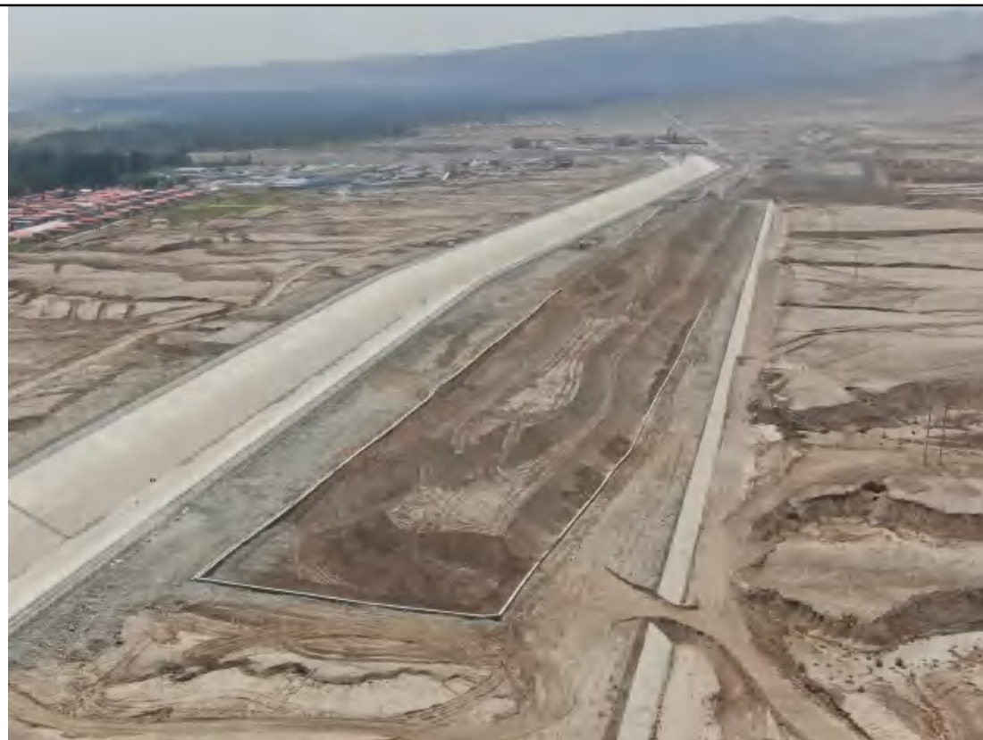
5-2#弃渣场（E76°38'13.31"，N37°53'27.14"）-西南侧
