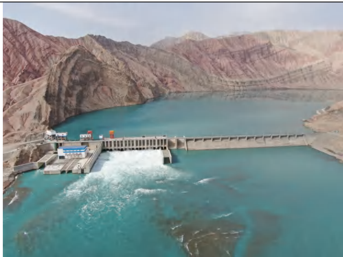
拦河引水枢纽
