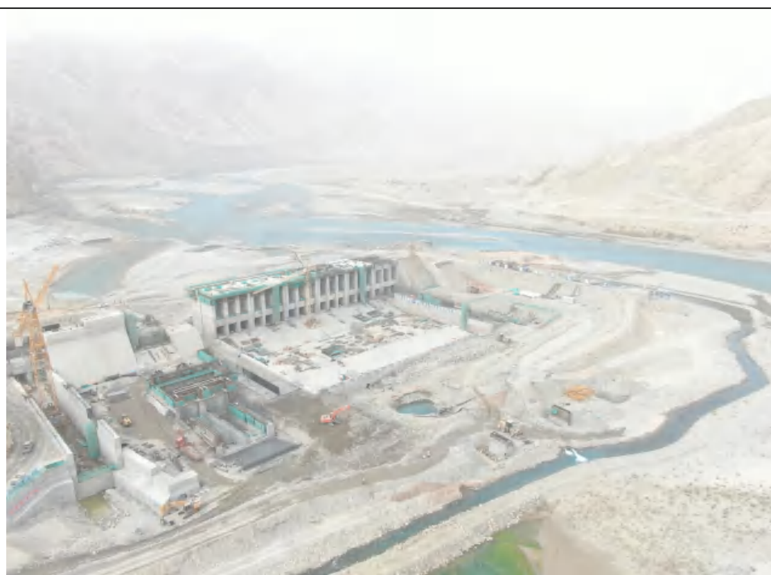
拦河引水枢纽
