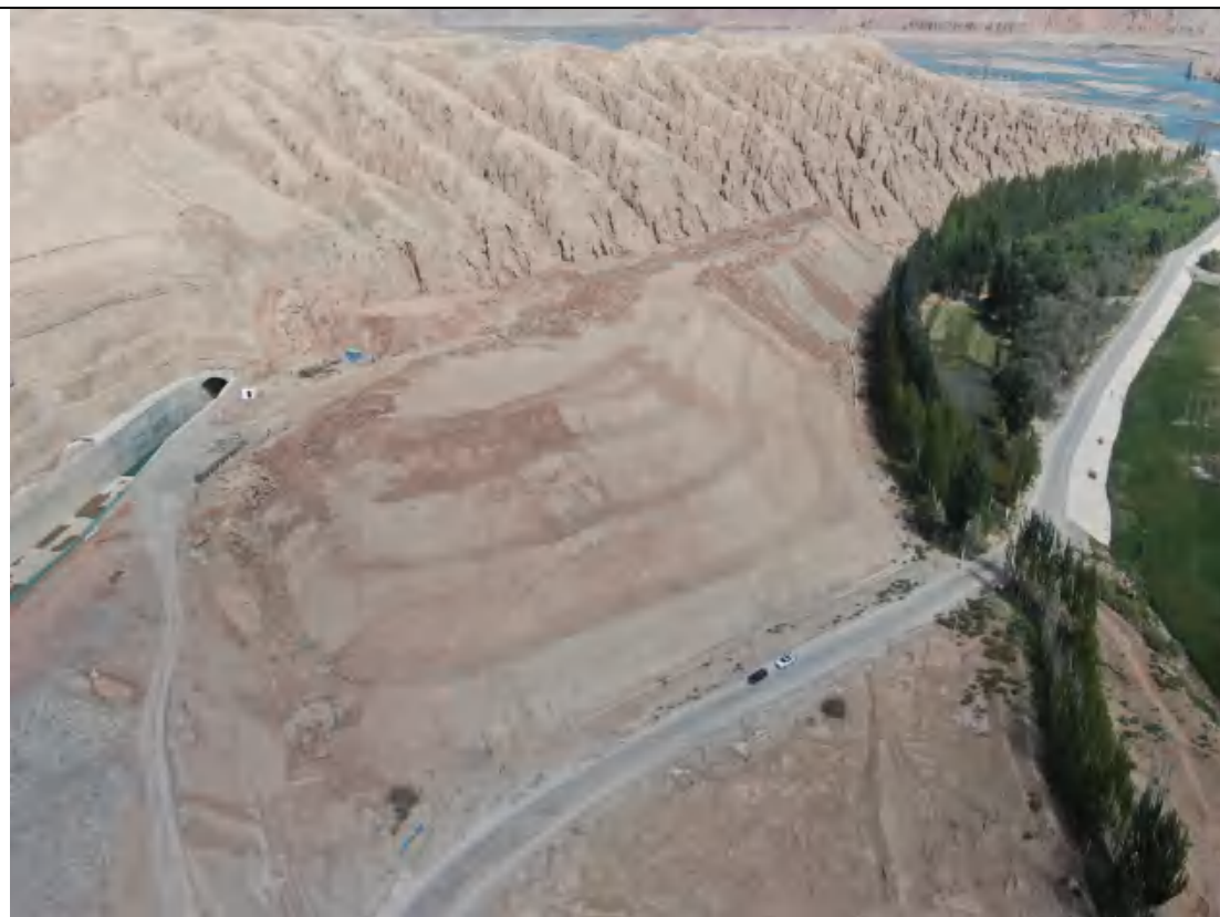
3#弃渣场 (E76°36'6.43", N37°54'47.00") - 西北侧
