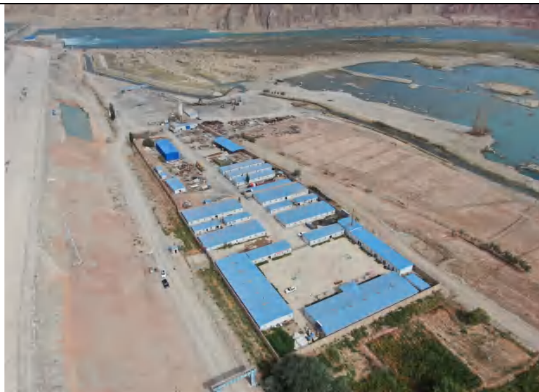
1 标-水电十五局施工生产生活区 (E76°34'24.54", N37°55'27.10")
