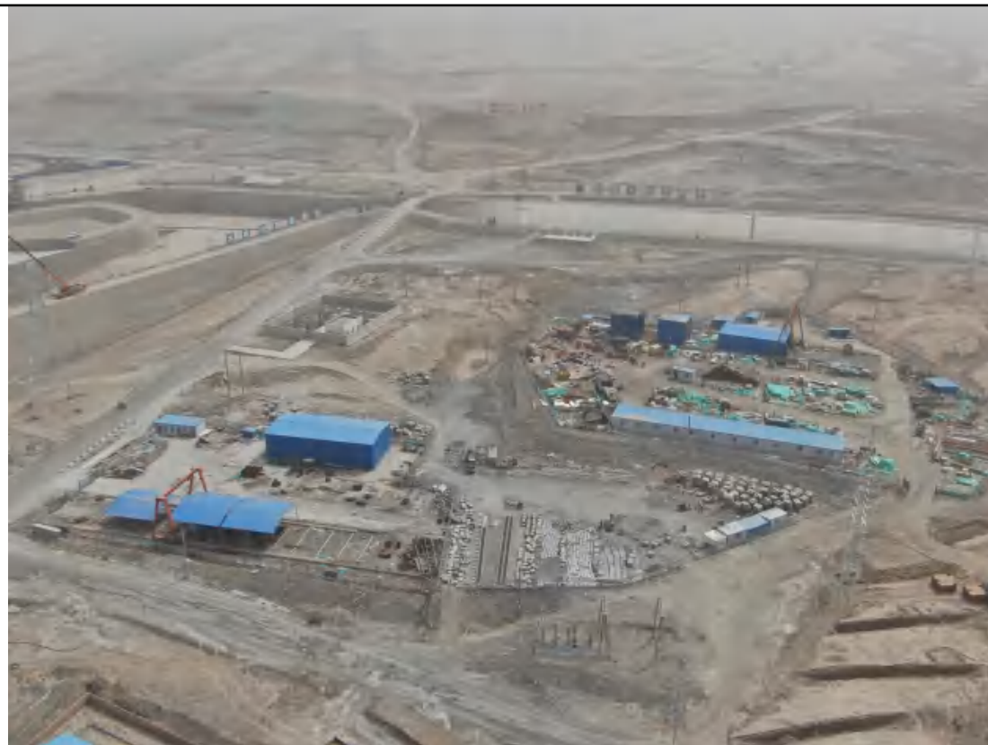
5 标-水电十一局施工生产生活区 (E76°38'51.55", N37°53'25.15")
