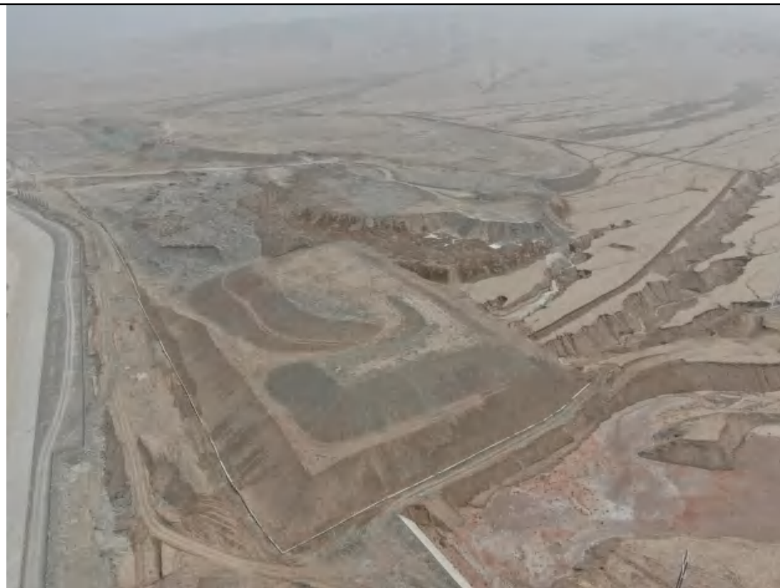
6#弃渣场 (E76°38'35.67", N37°53'15.81") -西北侧
