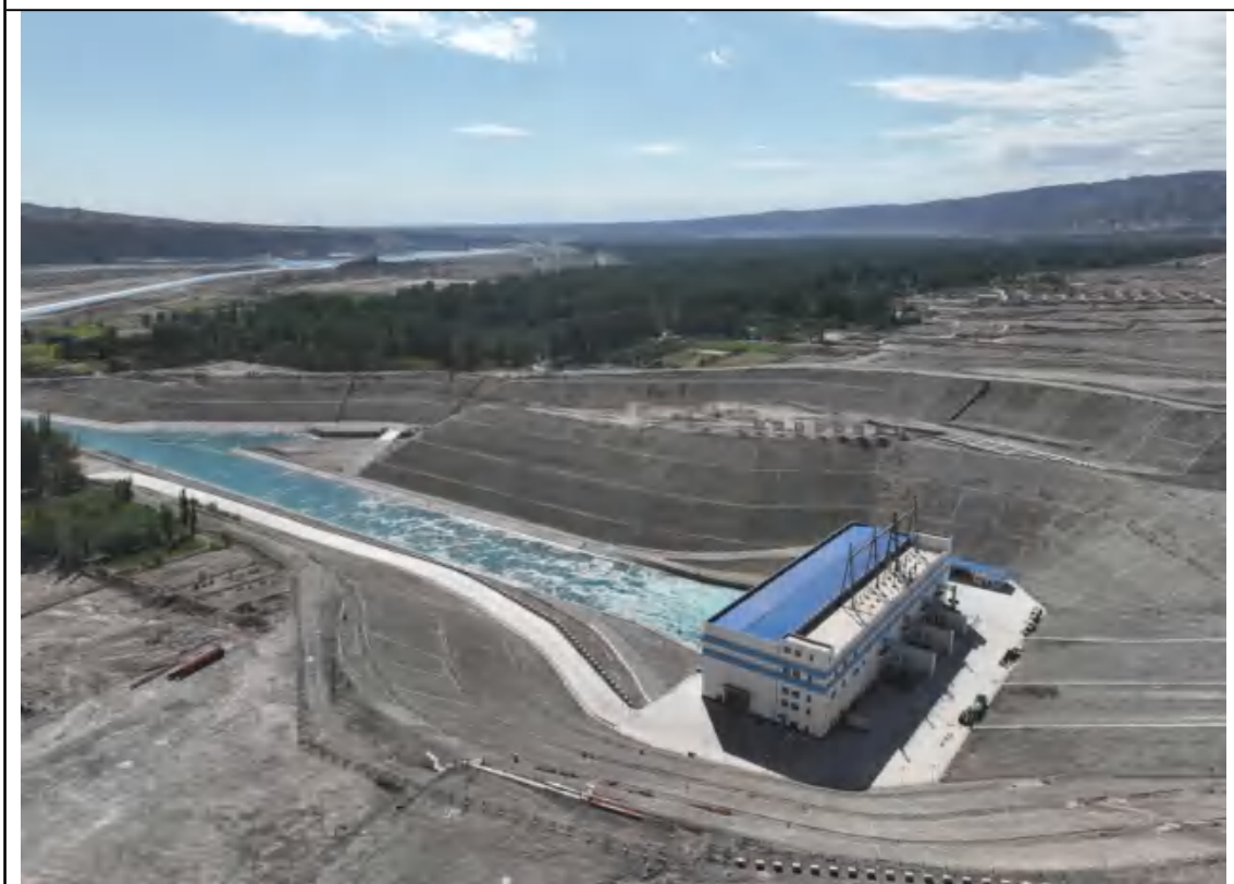
发电厂房、泄水陡坡
