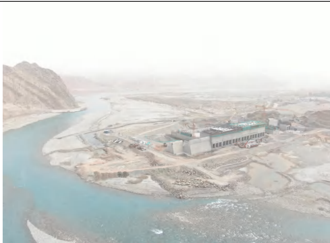
拦河引水枢纽
