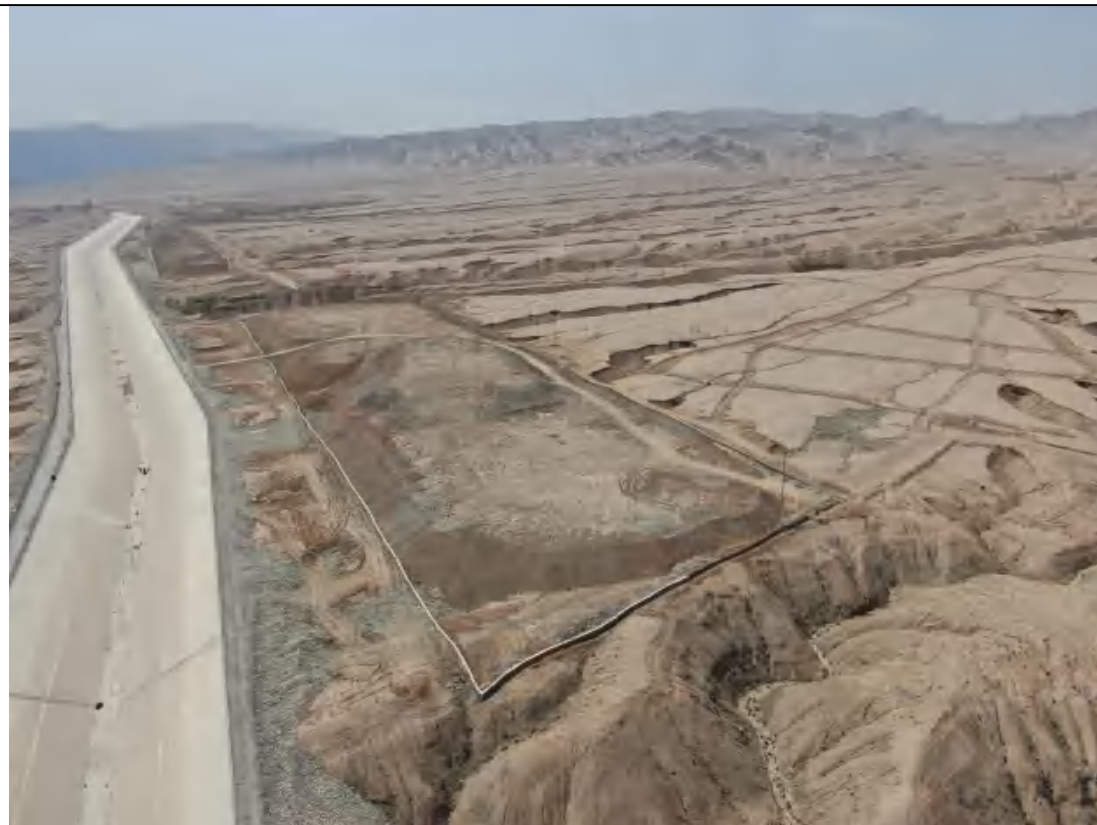
5-1#弃渣场 (E76°37'46.85", N37°53'38.01") -西北侧
