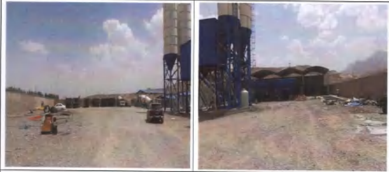
水电局拌合站
