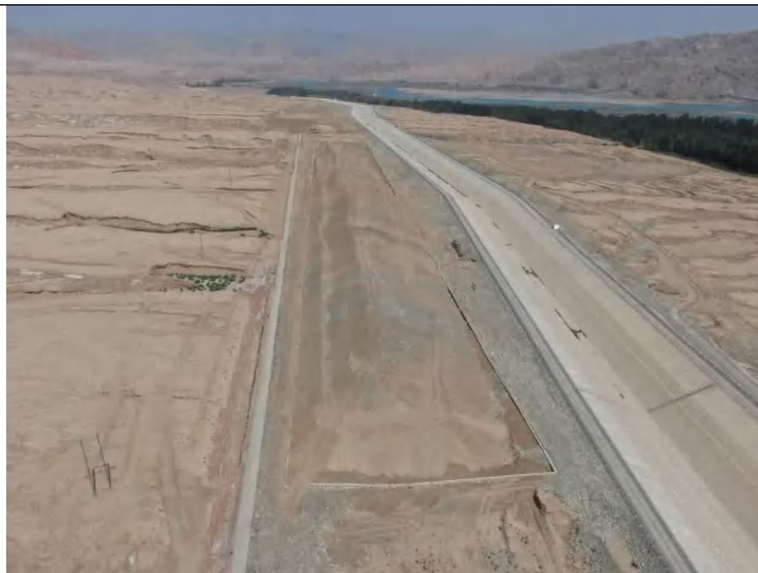
5-2#弃渣场（E76°38'13.31"，N37°53'27.14"）-东侧
