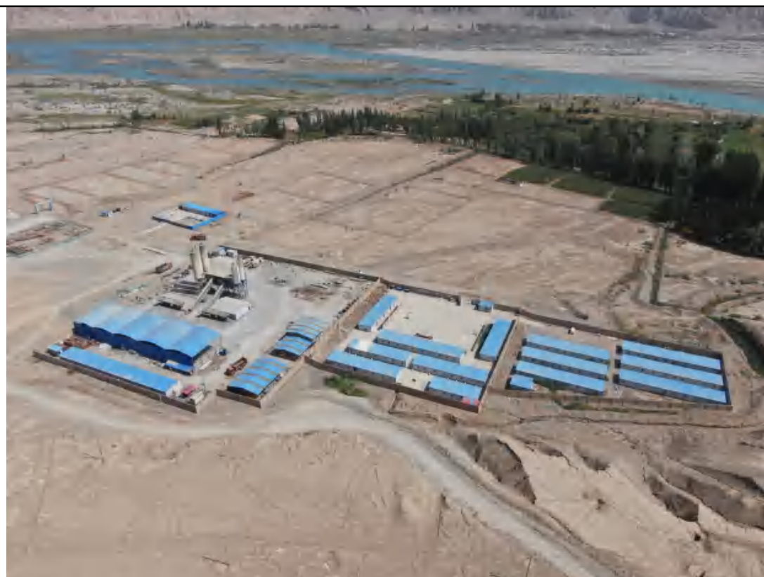
3 标-水电三局施工生产生活区 (E76°36'57.72", N37°54'19.94")
