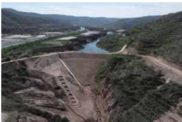
甘肃省定西市安定区骨干坝 除险加固工程
