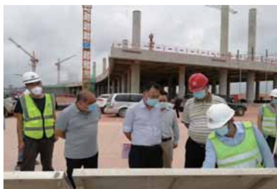
广东湛江机场迁建工程现场检查
