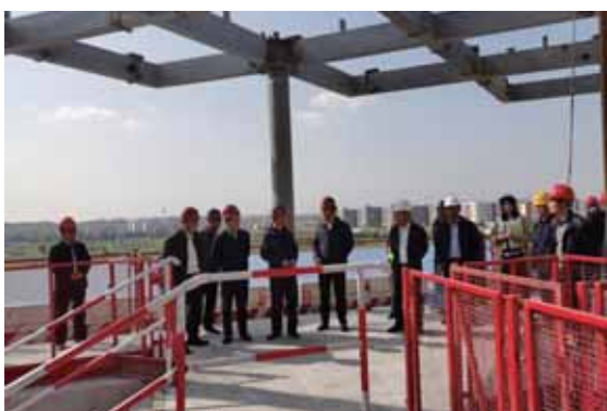
江苏南京至句容城际轨道交通工程现场检查
