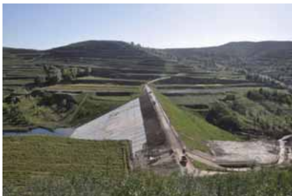
宁夏回族自治区隆德县骨干坝 除险加固工程
